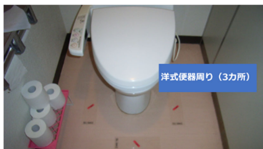
図7 病棟 洋式便座周辺（女性トイレ）
