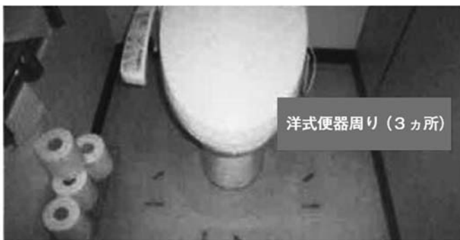
図7 病棟 洋式便座周辺 (女性トイレ)
